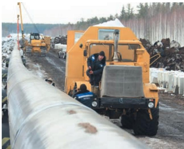
В результате реконструкции магистральный газопровод ПарABEL – Кузбасс будет иметь двухниточное исполнение на участке от нулевого до 404 километра
